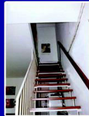
Treppe in der Wohnung
